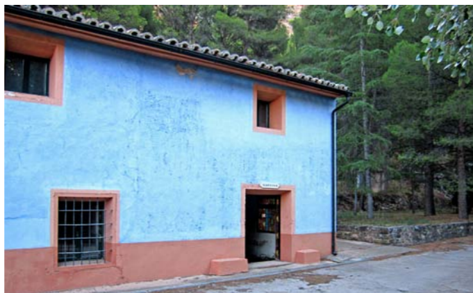
Edificio del pantano de Cueva Foradada en el que se colocó una capilla hacia 1960.
