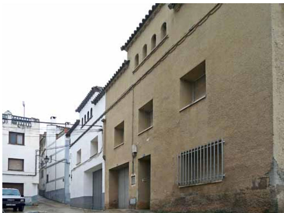
Fachada del cine Capitol (foto Vicente Ibáñez).
