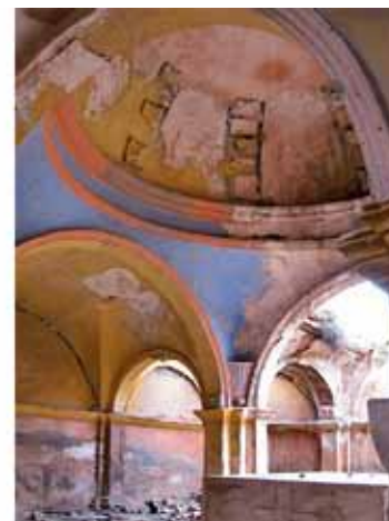
2.- Estado inicial de la ermita
