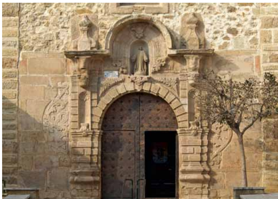
Portada de la iglesia, situada en el muro de los pies.
